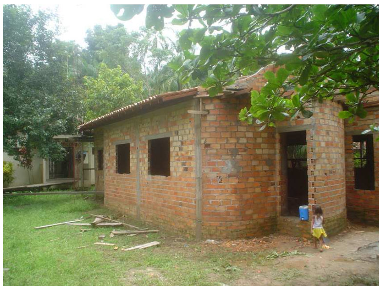
FIG. 26 – Igreja católica em construção no igarapé Combu. Foto do pesquisador, 2006.
